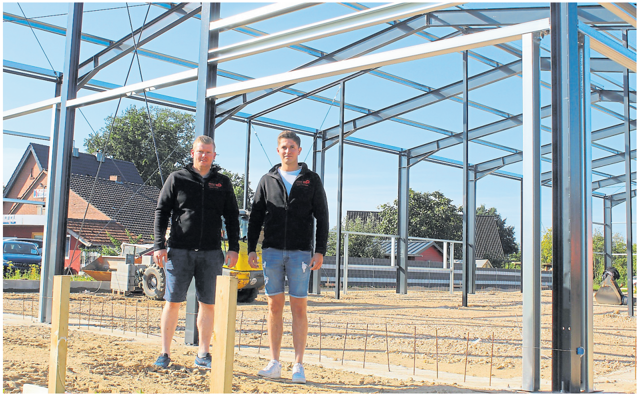
Metallbau Pruss soll auch künftig sichtbar sein, betonen die Geschäftsführer Daniel Pruss (l.) und Gerrit Vorndieck vor der Baustelle ihres neuen Firmengebäudes an der Ibbenbürener Straße.
